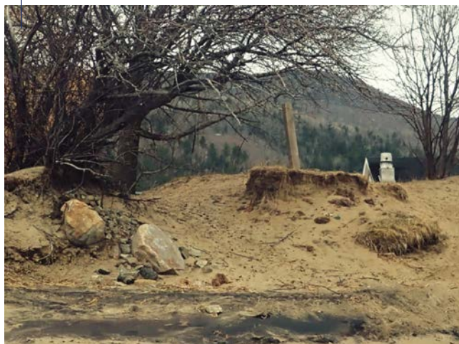
Érosion au Parc des Riverains de Petite-Rivière-Saint-François avant l'implantation des boudins végétalisés
